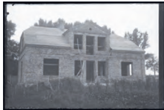
Budowa domu Witaczyńskich – front, 21 sierpnia 1938 r.
